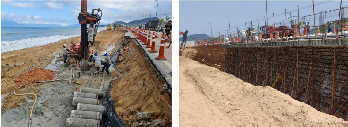
**Figura 33** - Execução do muro de contenção. Fonte: DER, 2021.
