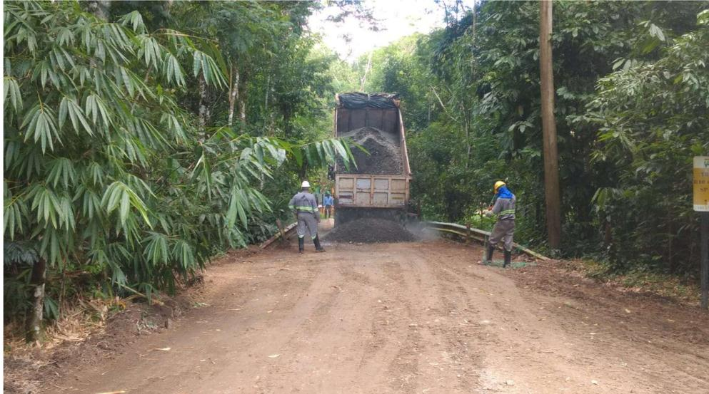
Figura 2: Despejamento do material já em solo preparado. Fonte: Autor.
