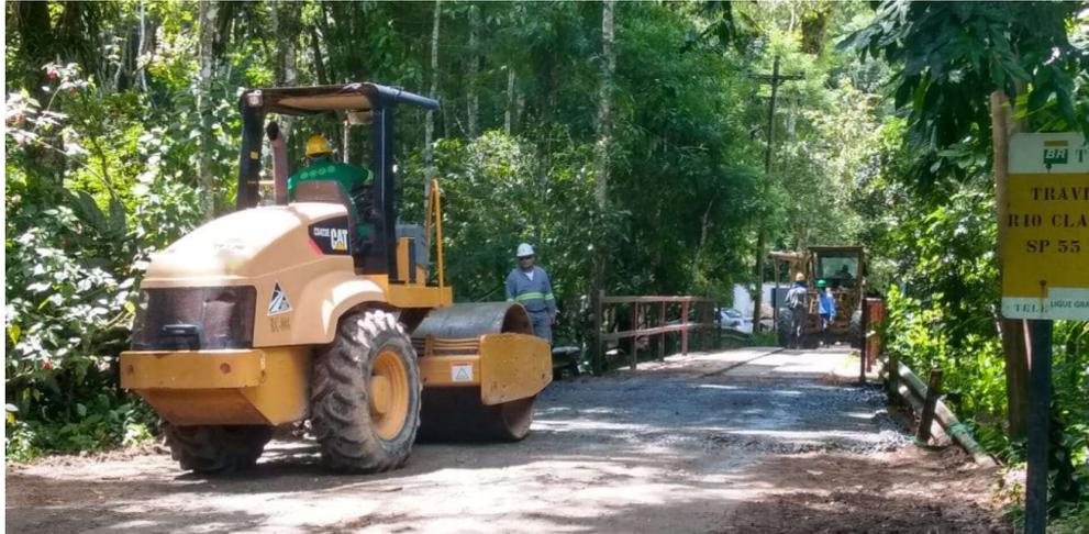
Figura 4: Compactação com rolo vibro acabador. Fonte: Autor.
