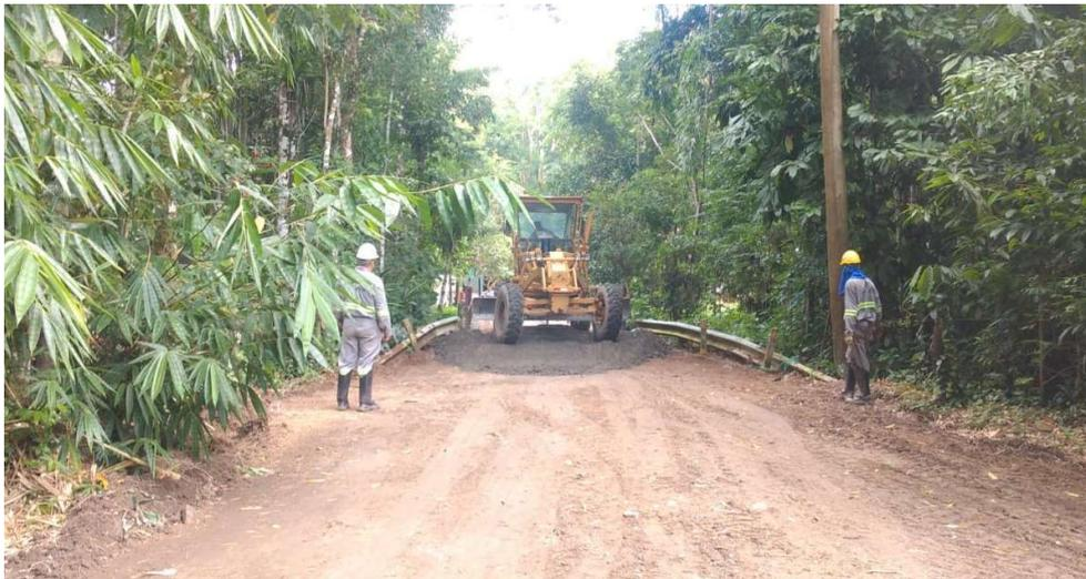
Figura 3: Distribuição do material pelo terreno com motoniveladora. Fonte: Autor.
